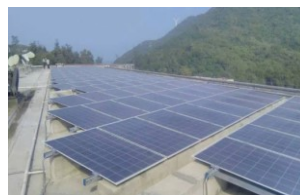
屋面敷设光伏板
